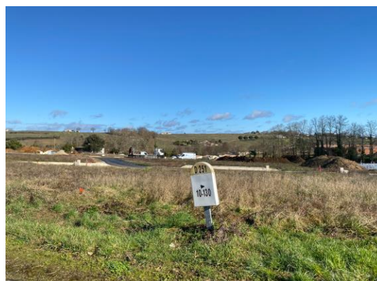
Logements en construction // Source : crédit photo MERC/AT
