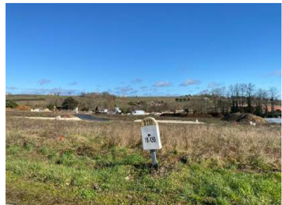
Logements en construction // Source : crédit photo MERC/AT
