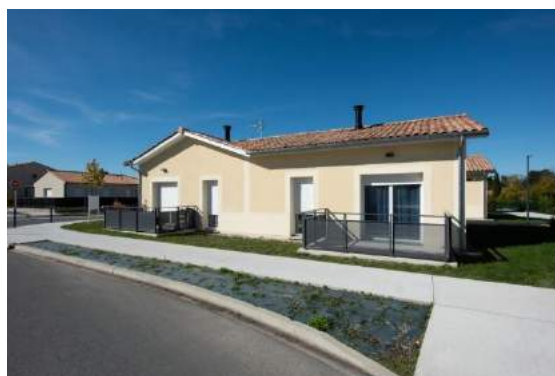
Logement de la résidence Jean Mermoz destiné à la colocation pour senior. Source : Girondehabitat.fr
