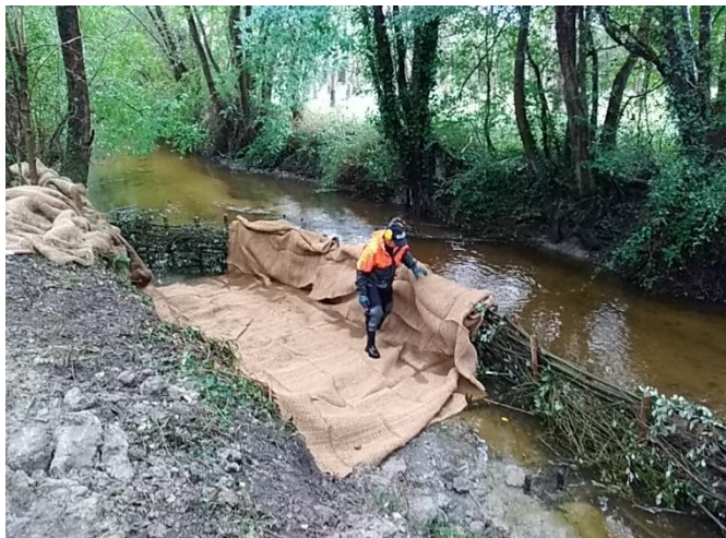
Fig 11 et 12. Travaux de diversification des écoulements réalisés en régie
