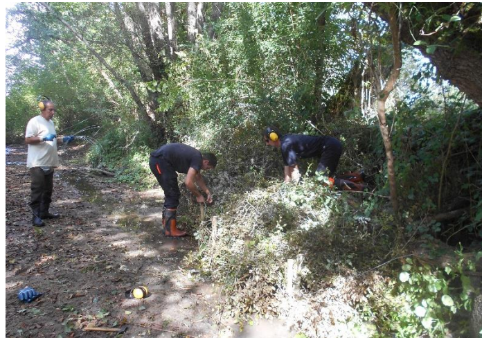
Fig 6. Réalisation d'un aménagement pour la diversification des écoulements
