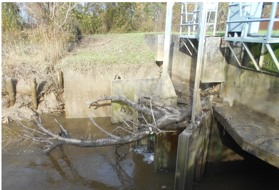
Fig 11. Exemple d'intervention aux portes à flots du Moron
