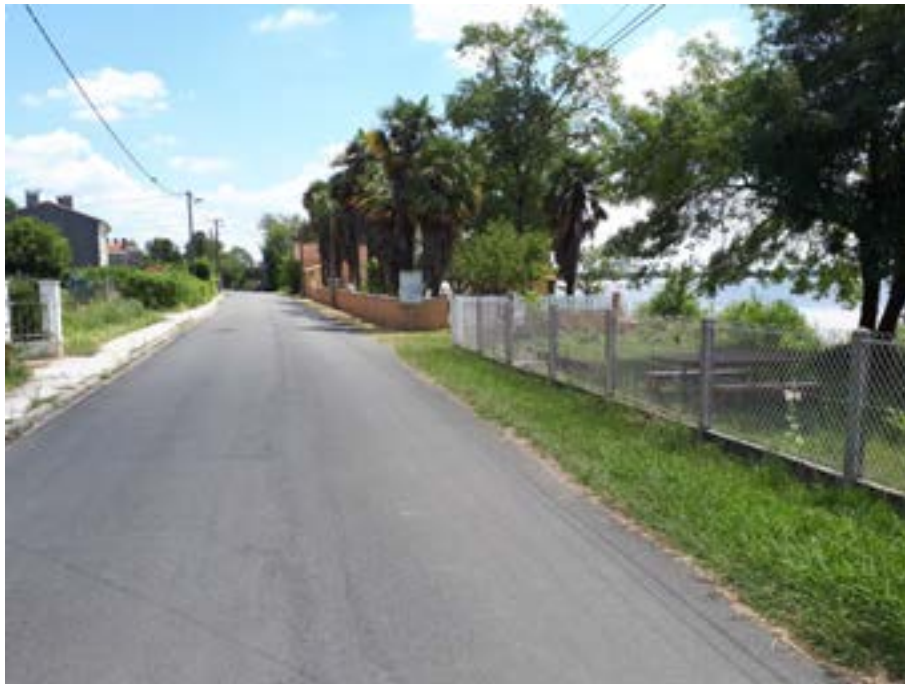
Figure 18: Secteur du Pain de Sucre sans ouvrage de protection
