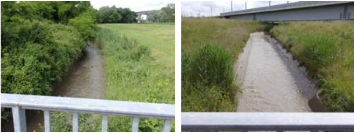
Photo 4: Tronçon de Virvée canalisé
