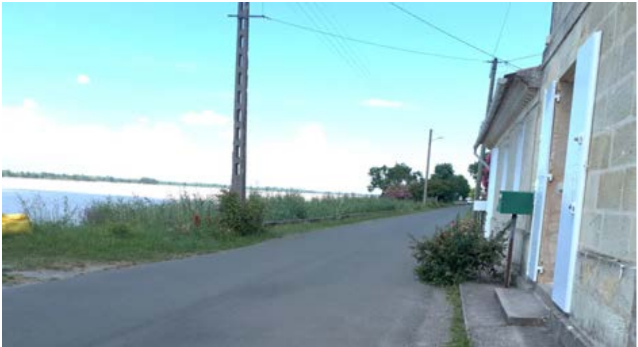
Figure 16: Muret de protection en aval de la route de la corniche (Marmisson/Gauriac)
