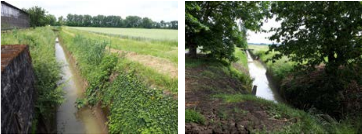
Figure 7: Estey Giraudeau en aval du bassin versant
